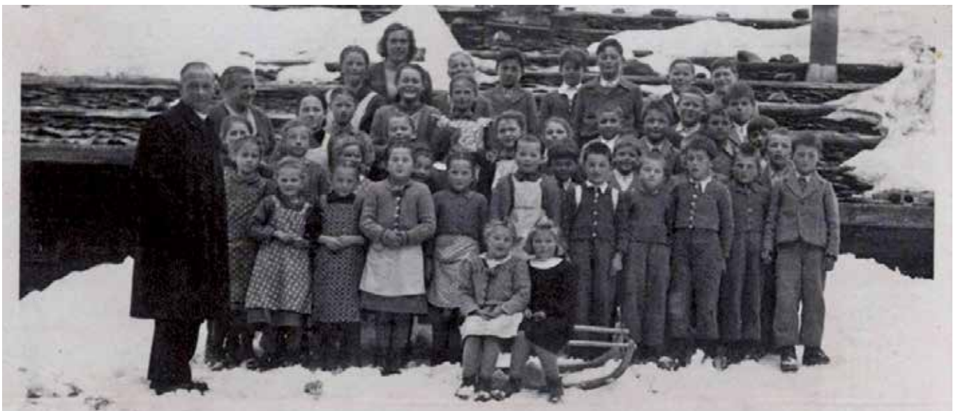
Im Winter 1950 – 51 hatte es in St. Helena, so weiß Serafin Tratter zu erzählen, ungefähr 16 bis 17 Meter Schnee gemacht (Neuschnee gemessen). Als der Schnee vom Dach des Widums rutschte, wurde unten ein Verbindungstunnel durch die Schneemassen gegraben. Das Foto zeigt auch, dass die Schüler fast auf der Höhe der Dachtraufe stehen.
